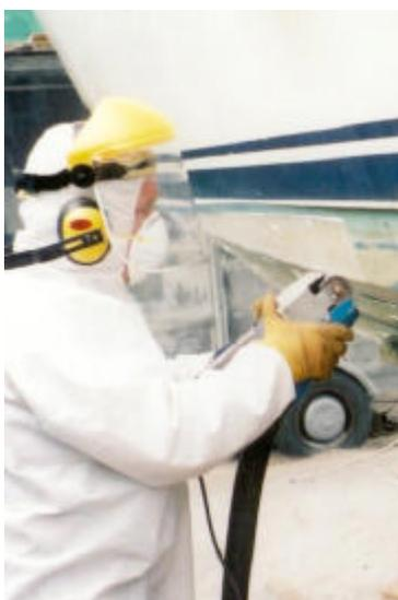
Negli ultimi anni questo è diventato il metodo più popolare per rimuovere le vecchie antivegetative e il gelcoat. Le antivegetative, anche se già impiegate sulla carena durante la stagione, mantengono sempre un certo rischio di tossicità. Le macchine pelatrici hanno il vantaggio di intrappolare entrambi i materiali rimossi aspirandoli in contenitori, senza pericolo tossicologico, rispettando l'ambiente circostante e, allo stesso tempo, lasciando inalterato il profilo dello scafo.
